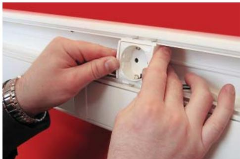
Защёлкиванием установите каркас с электроустановочным изделием в короб
