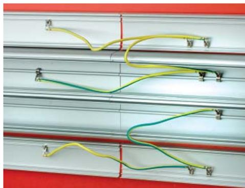
Проводами (код E0001BC) соедините основание одного из коробов с его крышками. Рекомендуем устанавливать клеммы провода (код E0001BC) на дно короба на расстоянии 16 см от клемм провода (E0001B). Оставшиеся клеммы проводов (код E0001BC) установите на направляющие, расположенные на внутренних сторонах крышек.
